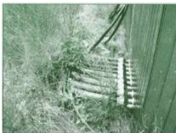
Перфоровані труби, що йдуть під землю
