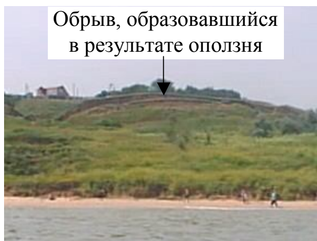
Рис. 2. Общий вид оползня
