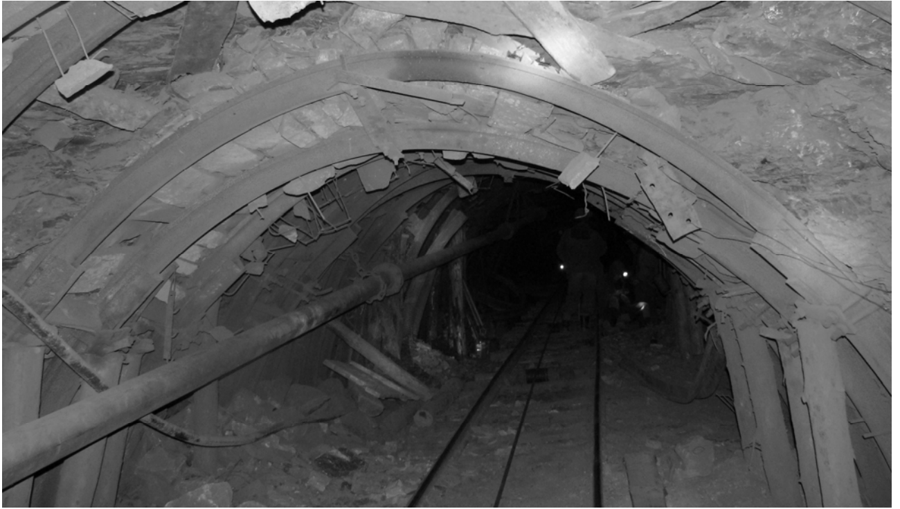
Рис. 2 Общий вид ходка до перекрепления
