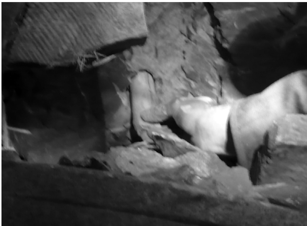
Рис. 4. – Установка ампул в шпур
