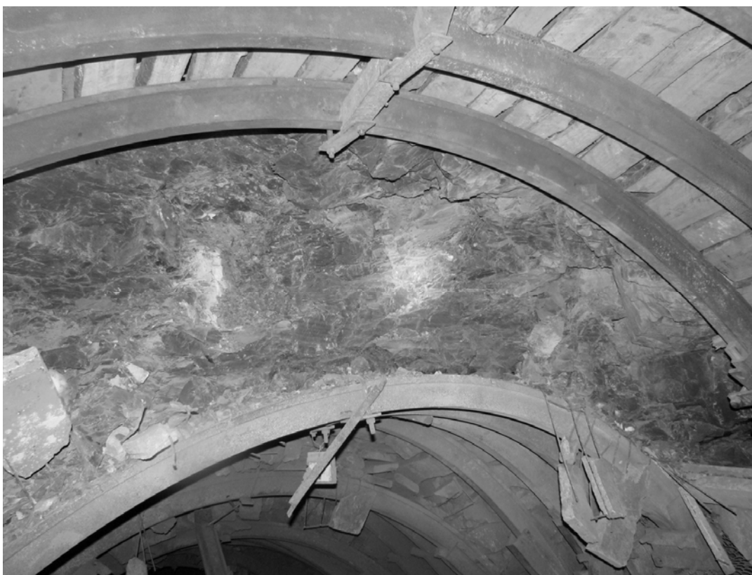
Рис. 5. Общий вид кровли грузового хода уклона пл. m_4^0 гор. 450 м после демонтажа деформированной рамы крепи на экспериментальном участке
