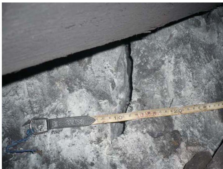
Рис. 8 – Общий вид разрушенной породы в забое подрывки.
