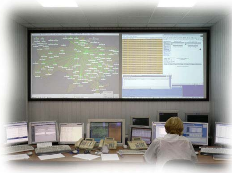
Рис.2. Система відображення диспетчерської інформації на базі проєкційної системи.
