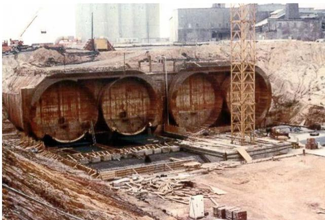
Рис. 5.11 Секции туннеля Макгенри в сухом доке
