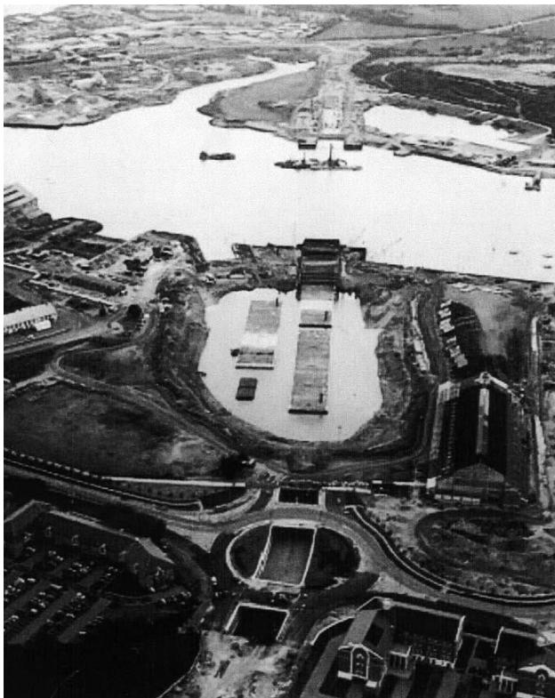
**Рис. 5.18** Туннельная секция в частично заполненном бассейне
