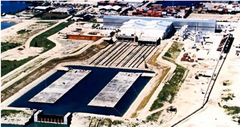
**Рис. 5.5** Всплытие туннельных секций при заполнении бассейна
