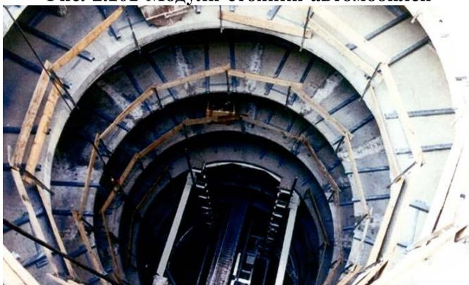
**Рис. 2.102 Размещение лифтовой системы в парковочном цилиндре**
