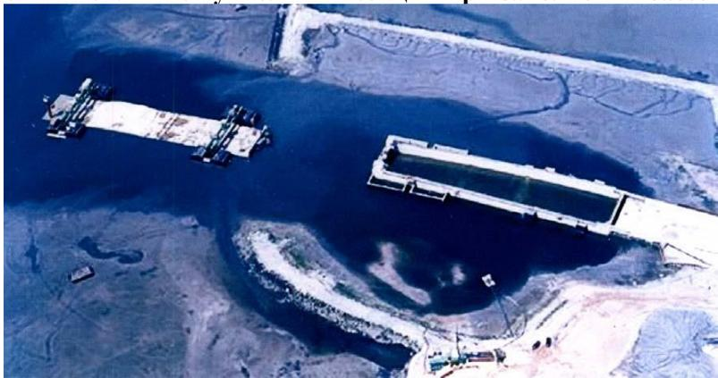
**Рис. 5.6** Выход туннельной секции за пределы бассейна
