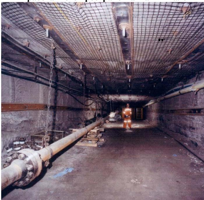
**Рис. 1.27** Трубопровод для транспортировки закладочной суспензии в выработки шахты Балби
