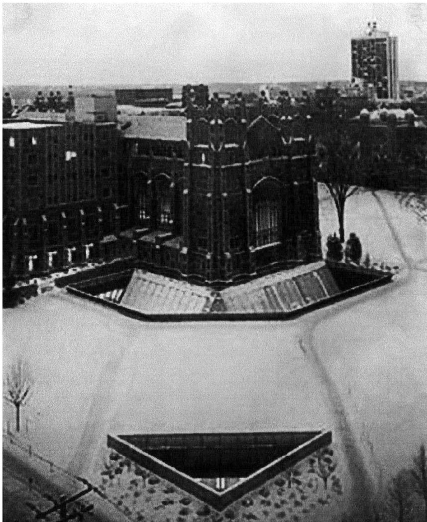
**Рис. 2.23** Связь подземной библиотеки с поверхностью
