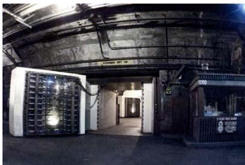
**Рис. 3.22** Взрывозащищенная дверь
