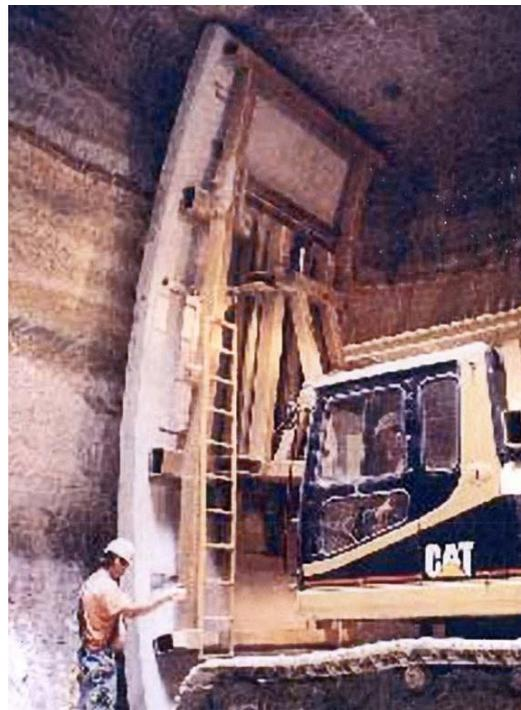
**Рис. 2.20 Установка изогнутых железобетонных панелей крепи полости подземной части библиотеки университета Миннесоты**
