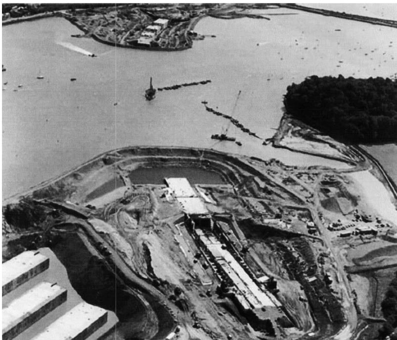
**Рис. 5.21** Строительство портала и заезда туннеля Конви
