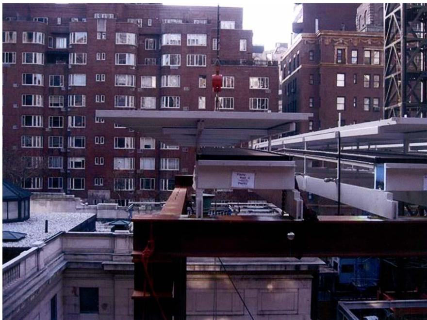
**Рис. 2.36** Монтаж конструкций в котловане подземной части библиотеки
