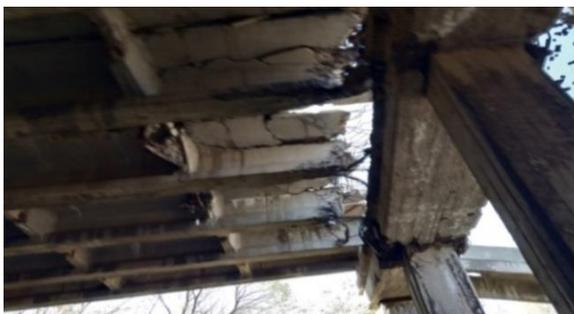
Рисунок 2 – Повреждения мостовых конструкций при взрыве
