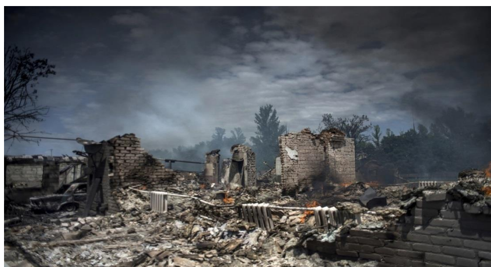
Рисунок 11 – Разрушенные жилые дома
