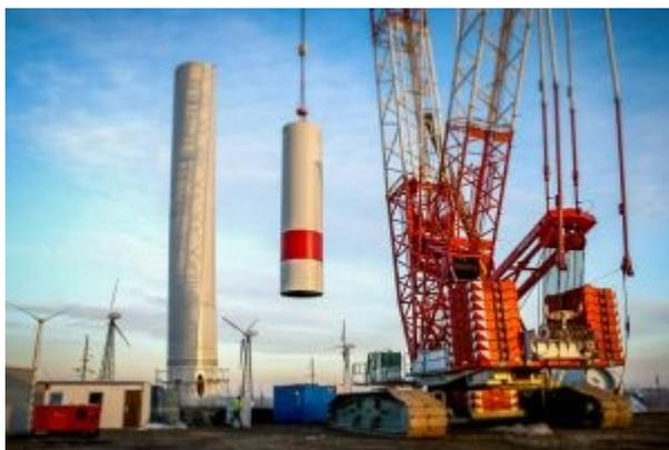
Рис.3. Монтажный кран для монтажа ветрогенератора
