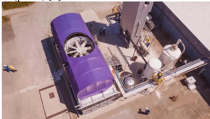
Рис.3. Пилотная установка прямого захвата воздуха в Британской Колумбии.
