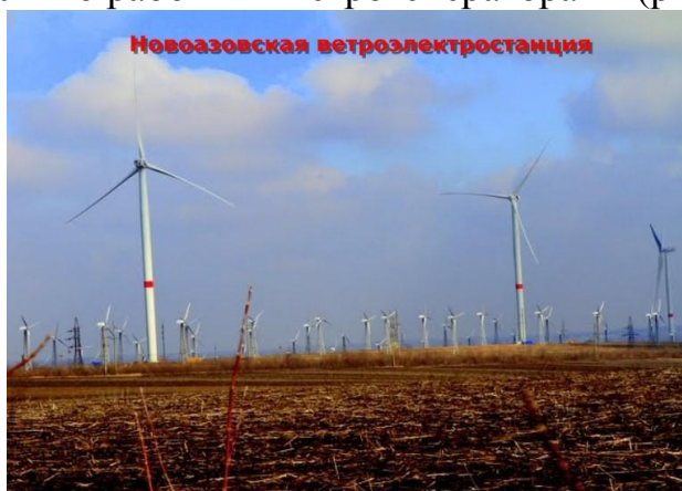
Рис. 2. Ветровая электростанция в Новоазовском районе ДНР
