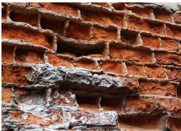
Рисунок 6 – Коррозия стен зданий: морозное разрушение, высоты
