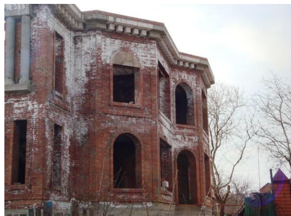
Рисунок 6 – Коррозия стен зданий: морозное разрушение, высоты
