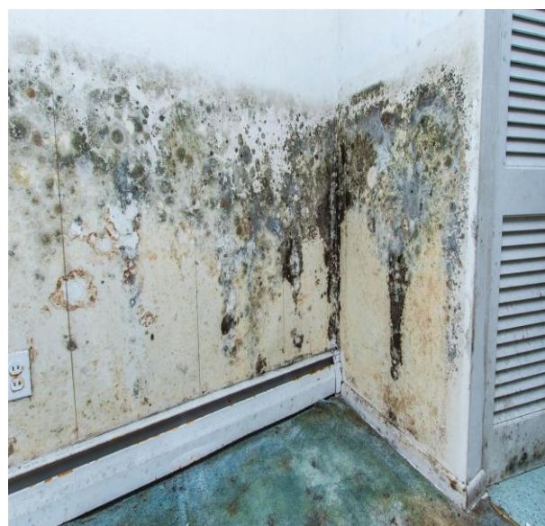
Рисунок 7 – Колонии грибов на наружной и внутренних стенах зданий
