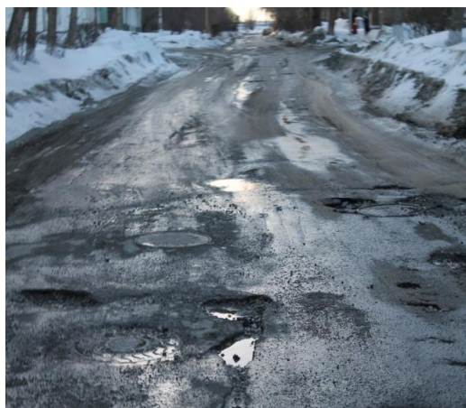
Рисунок 3 – Морозное разрушение дорожного покрытия
