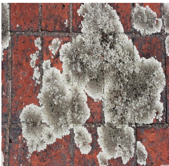
Рисунок 7 – Колонии грибов на наружной и внутренних стенах зданий
