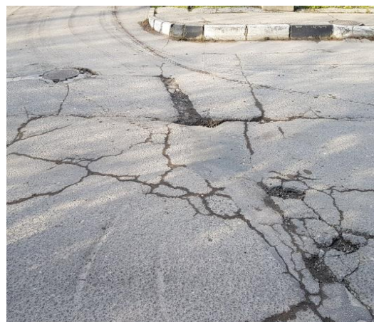
Рисунок 3 – Морозное разрушение дорожного покрытия
