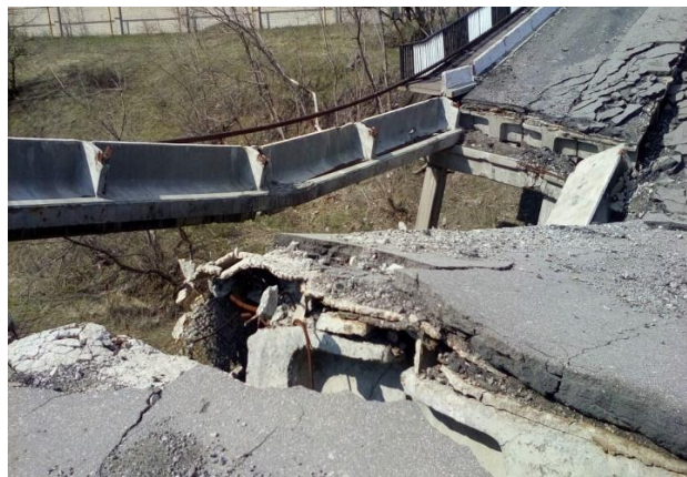
Рисунок 1 – Повреждение несущих элементов сооружения
