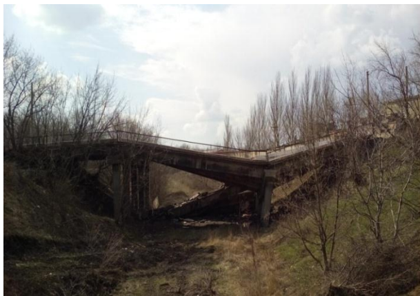
Рисунок 1 – Повреждение несущих элементов сооружения
