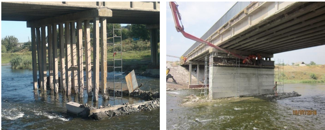
Рисунок 8 – Пример капитального ремонта поврежденной при взрыве опоры моста
