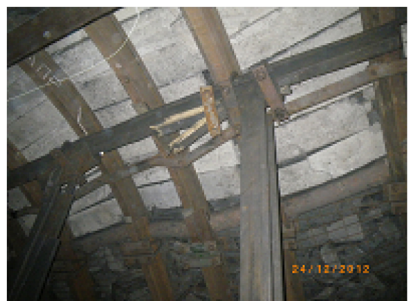
Рис. 2 – Состояние конвейерного штрека 11-й восточной лавы пласта k 3 при использовании продольно-балочной крепи усиления
