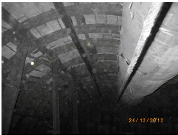
Рис. 2 – Состояние конвейерного штрека 11-й восточной лавы пласта k 3 при использовании продольно-балочной крепи усиления
