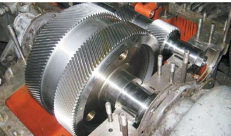
Рис. 1. Общий вид мультипликатора, подготовленного к визуальному осмотру
