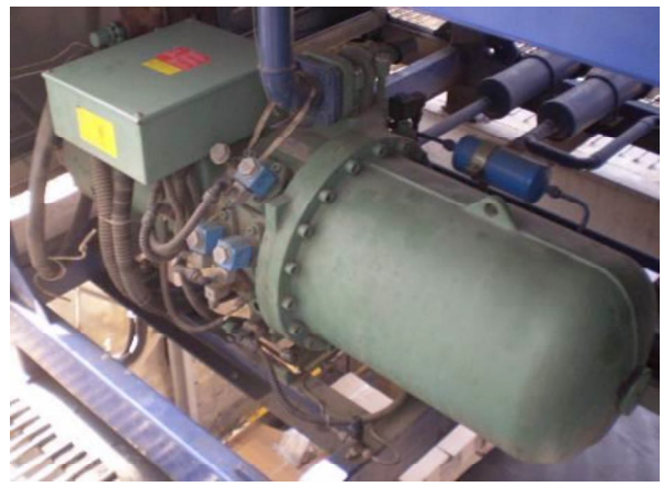
Рис. 1. Общий вид компрессорной установки с применением винтового компрессора
