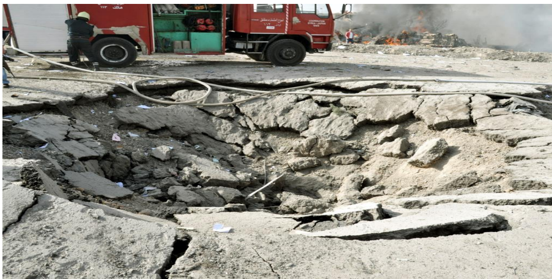
Рисунок 2 – Деформация земной поверхности в результате попадания снаряда
