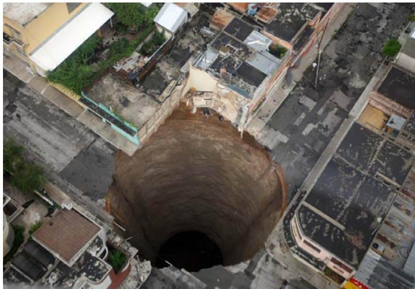
Рис.8 - Отверстие в Гватемале
