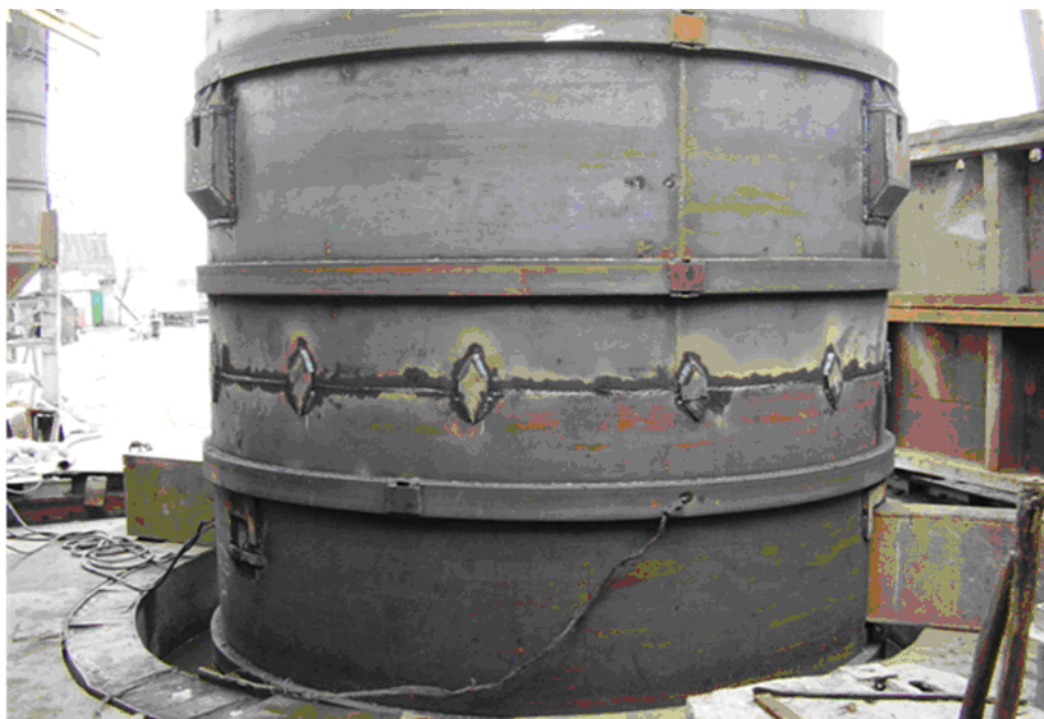
Рис.3 - Фотография верхнего участка обсадной колонны d=4,3 м перед посадкой на забой
