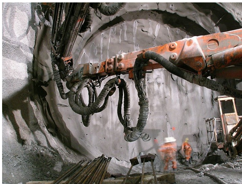
Рис. 5 - Гигантская буровая установка Sissi. Скорость проведения 25-30 м/сут.
