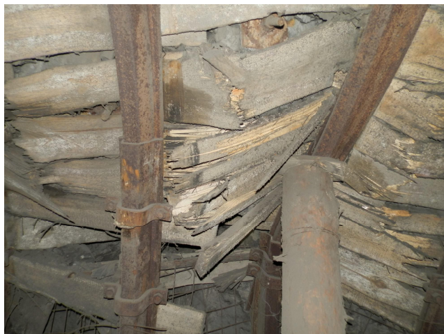
Рис. 1. Образование складок в кровле выработки
