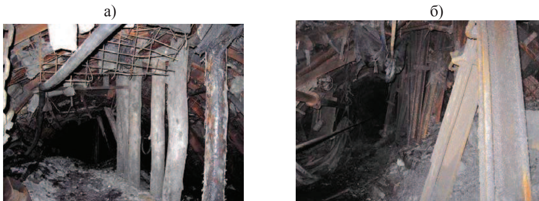
Рис. 4 – Состояние конвейерного штрека 8-й западной лавы пласта m_3 на участке установки деревянных (а) и металлических (б) стоек крепи усиления на деревянные лежни на расстоянии 60 м за очистным забоем
