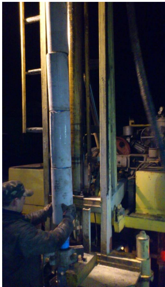
Рис. 5. Спуск КГФ в скважину
