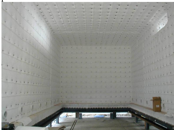
Рисунок 1 - Огнеупорная футеровка в отжигательных печах с выдвижным подом
