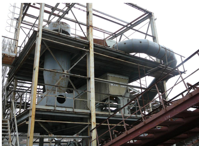
Рис. 1.29. Общий вид модульной установки в период монтажа
