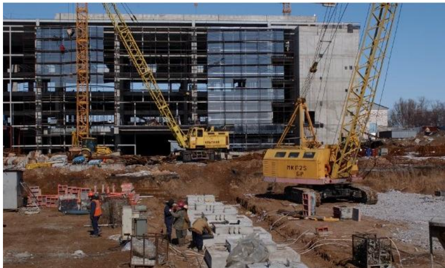
Рисунок 1.46 – Будівництво нового терміналу (фото)
