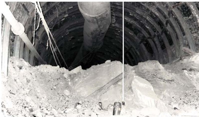
**Рис. 1** – Характер проявления пучения пород почвы в 8-м вост. конв. штреке пл.  $m_3$
