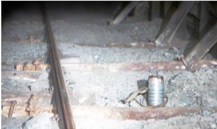
**Рис.3** – Размещение металлических лежней и опорных стоек по почвеконвейерного штрека 7-ой восточной лавы пласта  $l_8^1$  шахты «Лидиевка»
