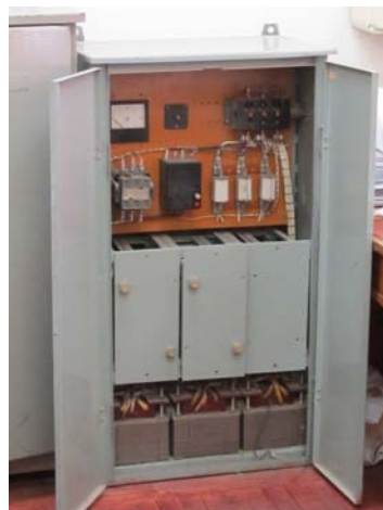
Рисунок 1 – Многофункциональный преобразователь напряжения на базе ВДТ
