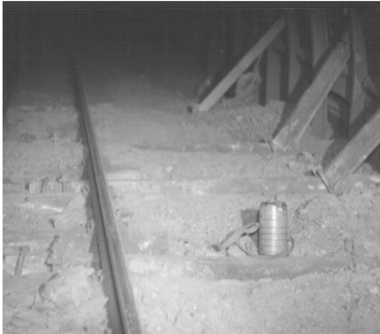
Рис. 5.3.9. Размещение металлических лежней и опорных стоек по почве конвейерного штрека 7-ой восточной лавы пласта l_8^1
