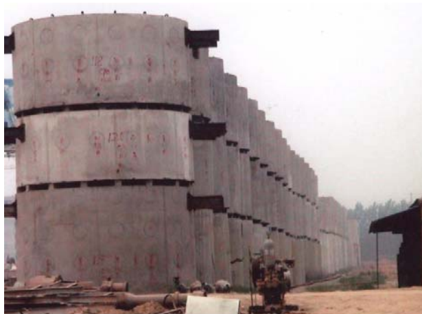
Рис. 3 - Секции сталебетонной крепи изготовленные на месте работ
