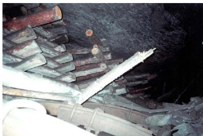
Рис. 1 – Сечение и фрагмент вывала кровли восточного разведочно-дренажного штрека до перекрепления
