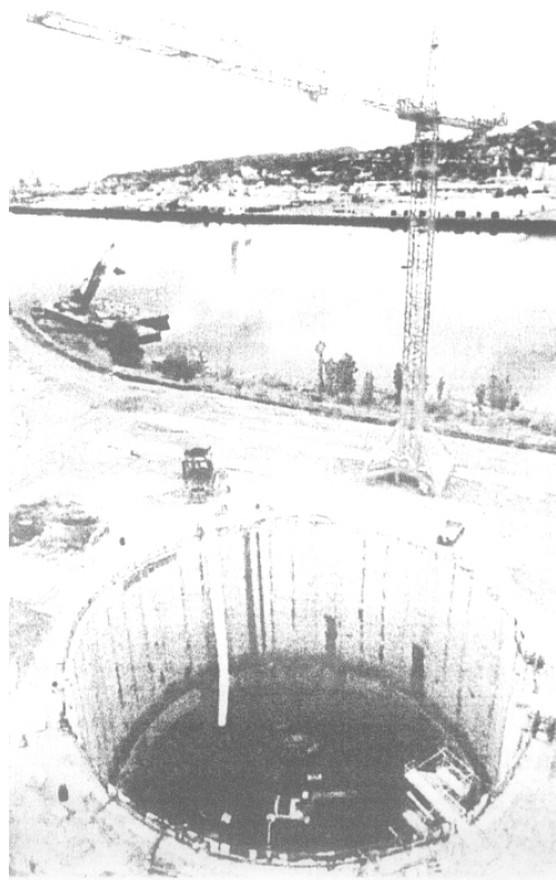
Рис. 2 Погрузка экскаваторами отбитой породы и подъем ее в бадьях краном
