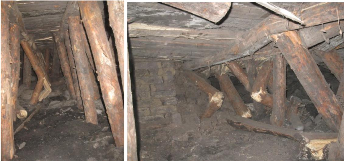
Рис. 8. Деформации стоек
