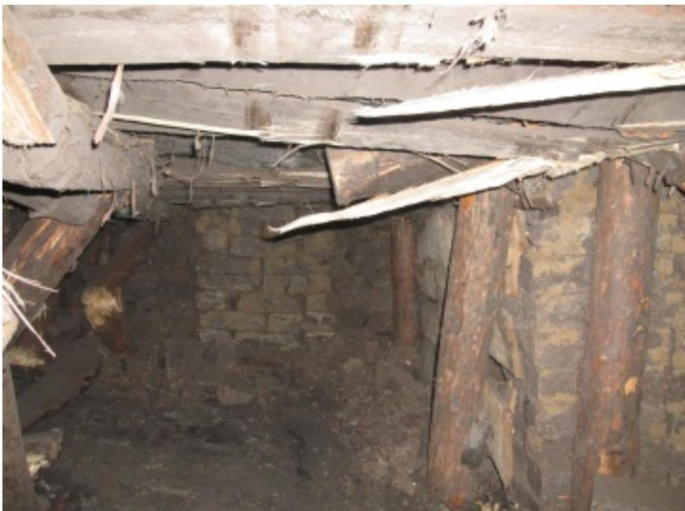
Рис. 9. Частичное разрушение полублоков в жесткой полосе
