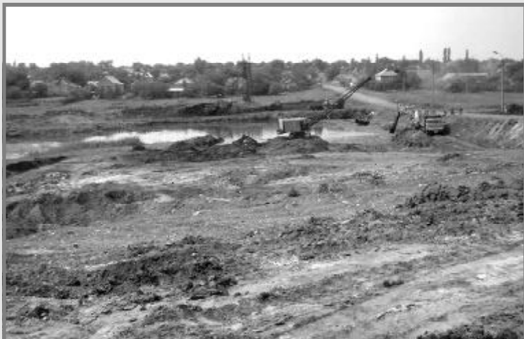
◆ Рисунок 8.1. - Работы по расчистке балки Осыковой.
