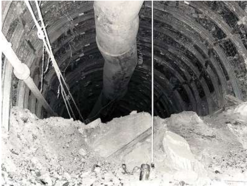
Рис. 2 – Подрывка пород почвы в 8-м восточном конвейерном штреке пласта m_3
