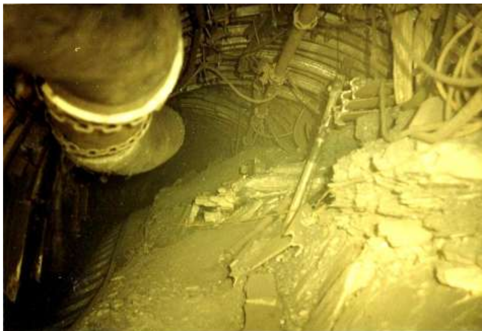
Рис. 5 – Состояние пород почвы конвейерного штрека 2-й западной лавы пласта h_{10} на расстоянии 120 м от очистного забоя
