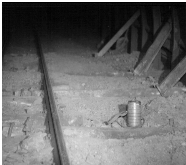
Рис. 5. Размещение металлических лежней и опорных стоек по почве конвейерного штрека 7-ой восточной лавы пласта l_8^1
