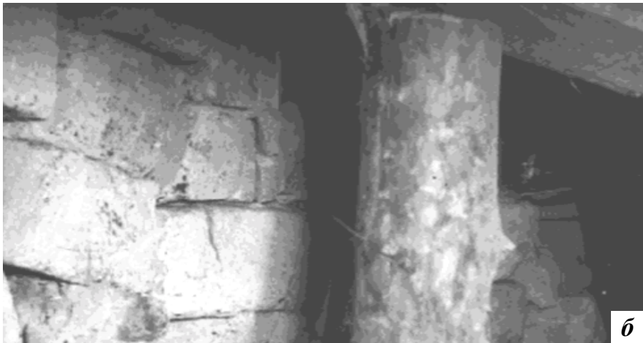
Рисунок 2 - Крепежные конструкции из газобетонных блоков в виде: а - тумбы (сопряжение 15-й восточной лавы пласта I 1 с вентиляционным штреком на шахте «Красногвардейская» ПО «Макеевуголь»); и б - сплошной полосы (3-й западный конвейерный ходок пласта I 1 на шахте «Машинская» ПО «Луганскуголь»)
