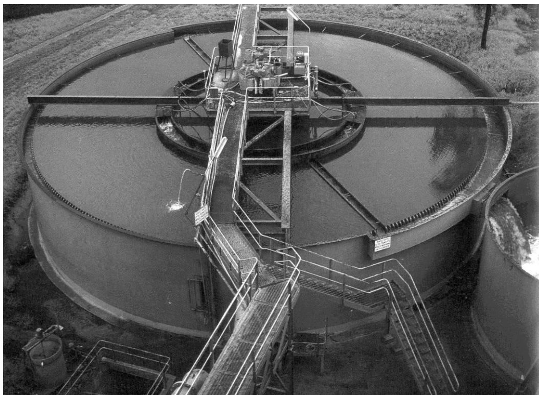
Рис. 18.2. Общий вид радиального сгустителя с центральным приводом
