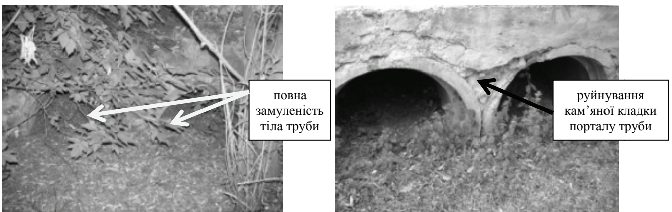
а) б) Рис. 6. Труба залізобетонна № 27 ПК56+480: а) вхідний оголовок; б) вихідний оголовок
