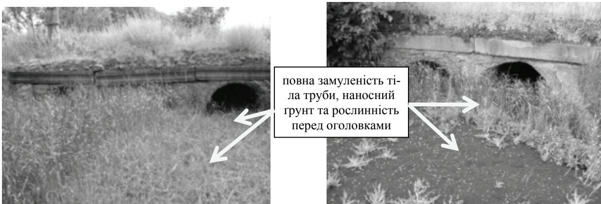
Рис. 11. Труба залізобетонна № 12, ПК31+400
