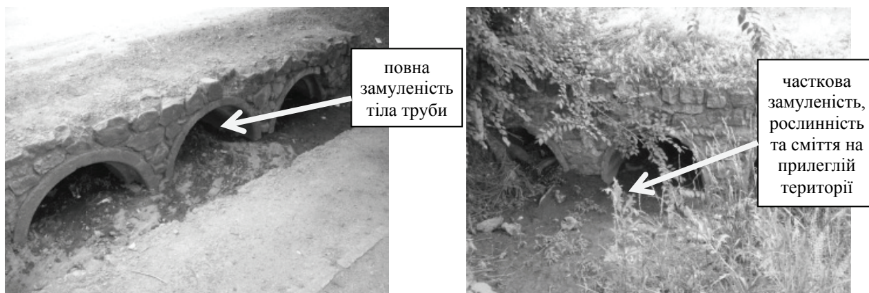
а) б) Рис. 7. Труба залізобетонна № 14 ПК33+840: а) вхідний оголовок; б) вихідний оголовок
