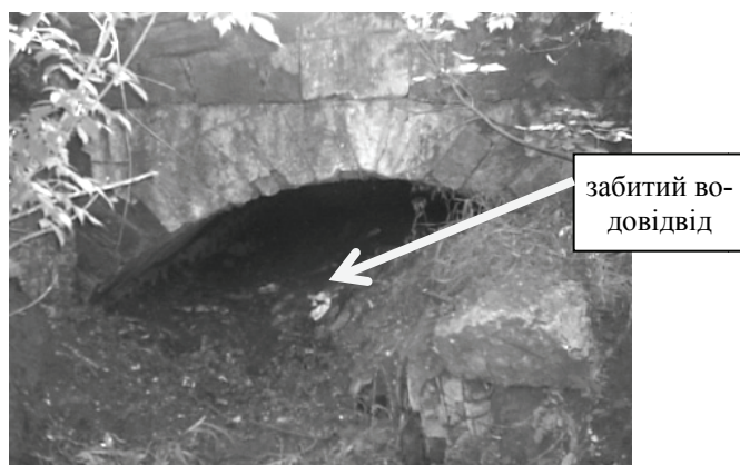
Рис. 1. Труба залізобетонна № 51, ПК95+360
