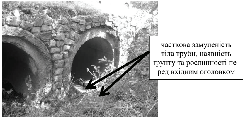
Рис. 11. Труба залізобетонна № 12, ПК31+400
