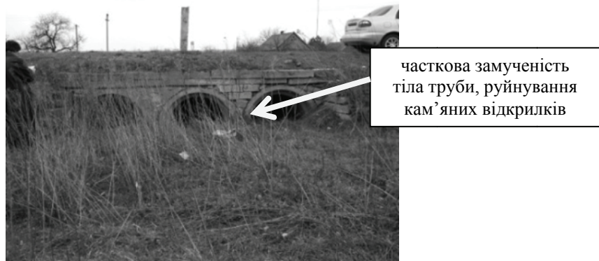
Рис. 10. Труба залізобетонна № 3, ПК7+338
