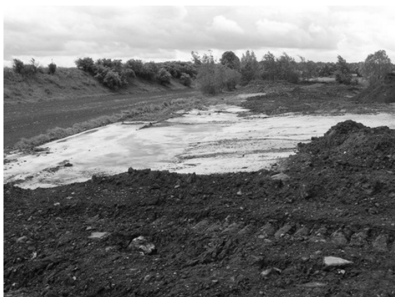
Fot. 7. Warstwa izolująca
