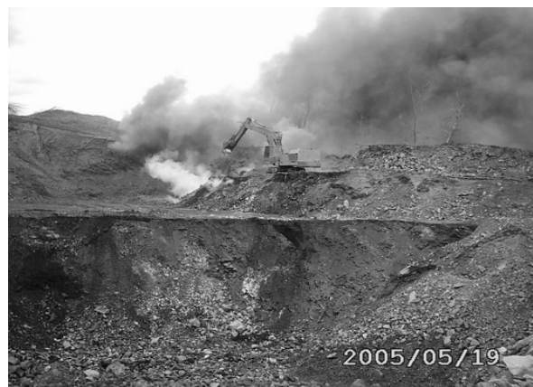
Fot. 2. Emisja pyłów w trakcie rozbiórki hałdy
