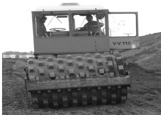
Fot. 6. Zagęszczanie materiału walcem
