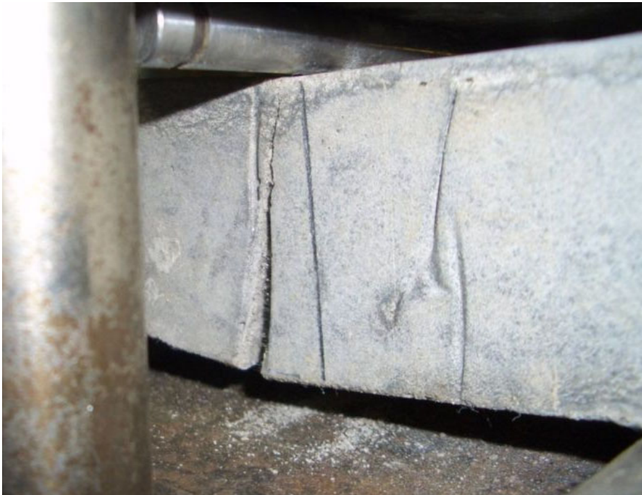
Рис. 1. Випробування бетонного зразка, армованого поліпропіленовими фібрами (1 %).
