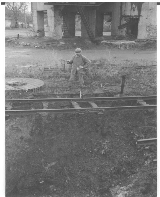
Фото 3 – Провал над главным наклонным стволом ш. № 20 «Постниковская» ПО «Шахтёрскантрацит»
