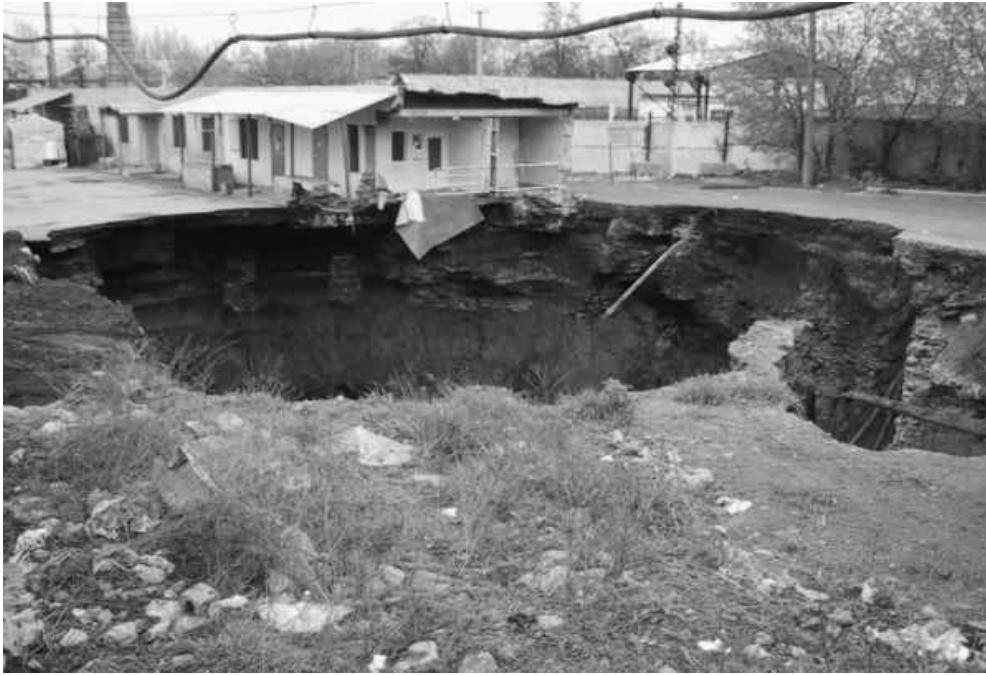
Фото 1 – Провал на устье старого вертикального ствола № 6-14 в Червоногвардейском районе г. Макеевки
