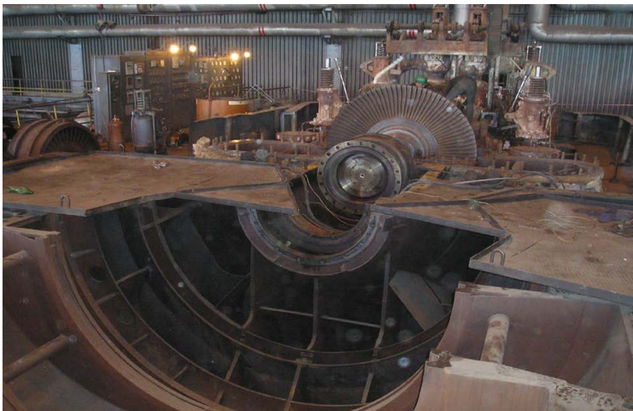
Рисунок 8 – Колесо турбіни
