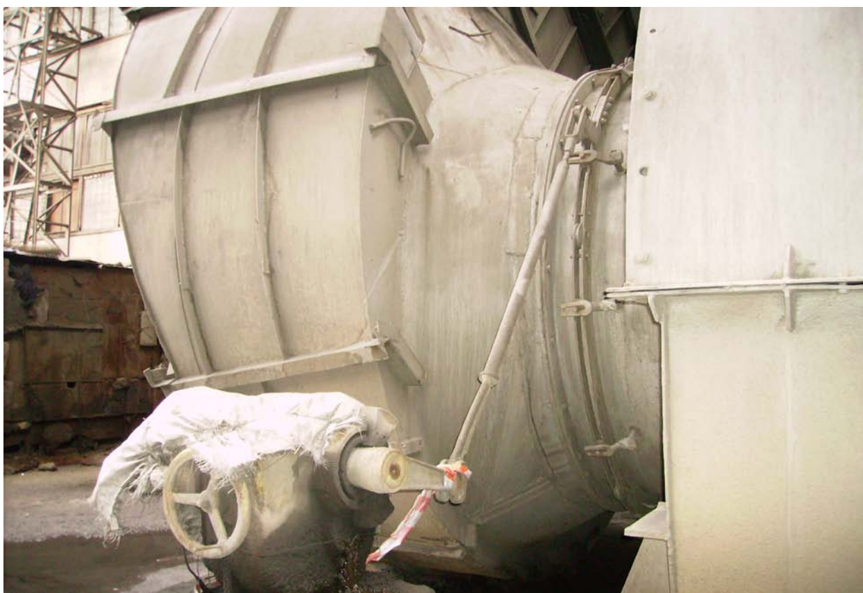
Рисунок 22 – Короб та направляючий апарат дутьєвого вентилятора
