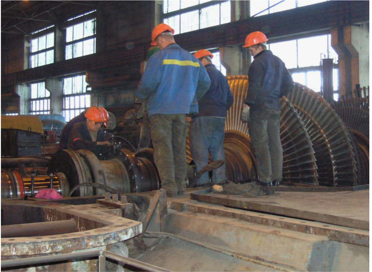
Рисунок 12 – Елемент циліндра низького тиску
