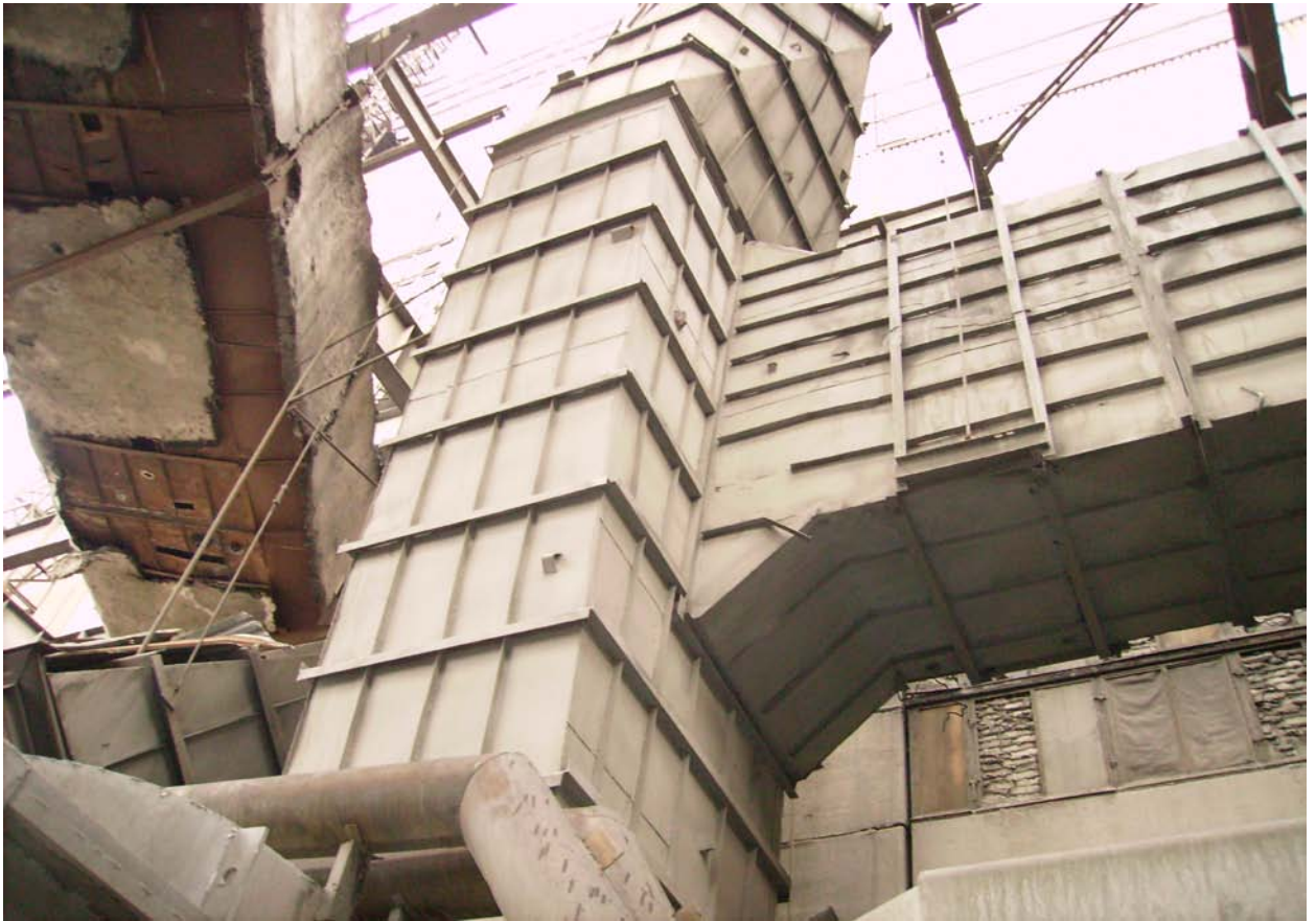
Рисунок 23 – Газоповітряний тракт вентилятора
