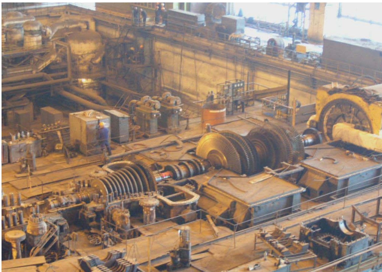
Рисунок 7 – Загальний вид турбіни у розібраному виді
