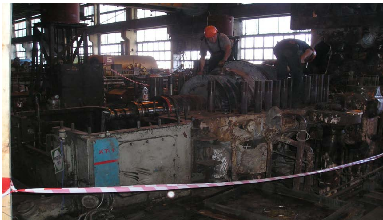
Рисунок 9 – Циліндр високого тиску
