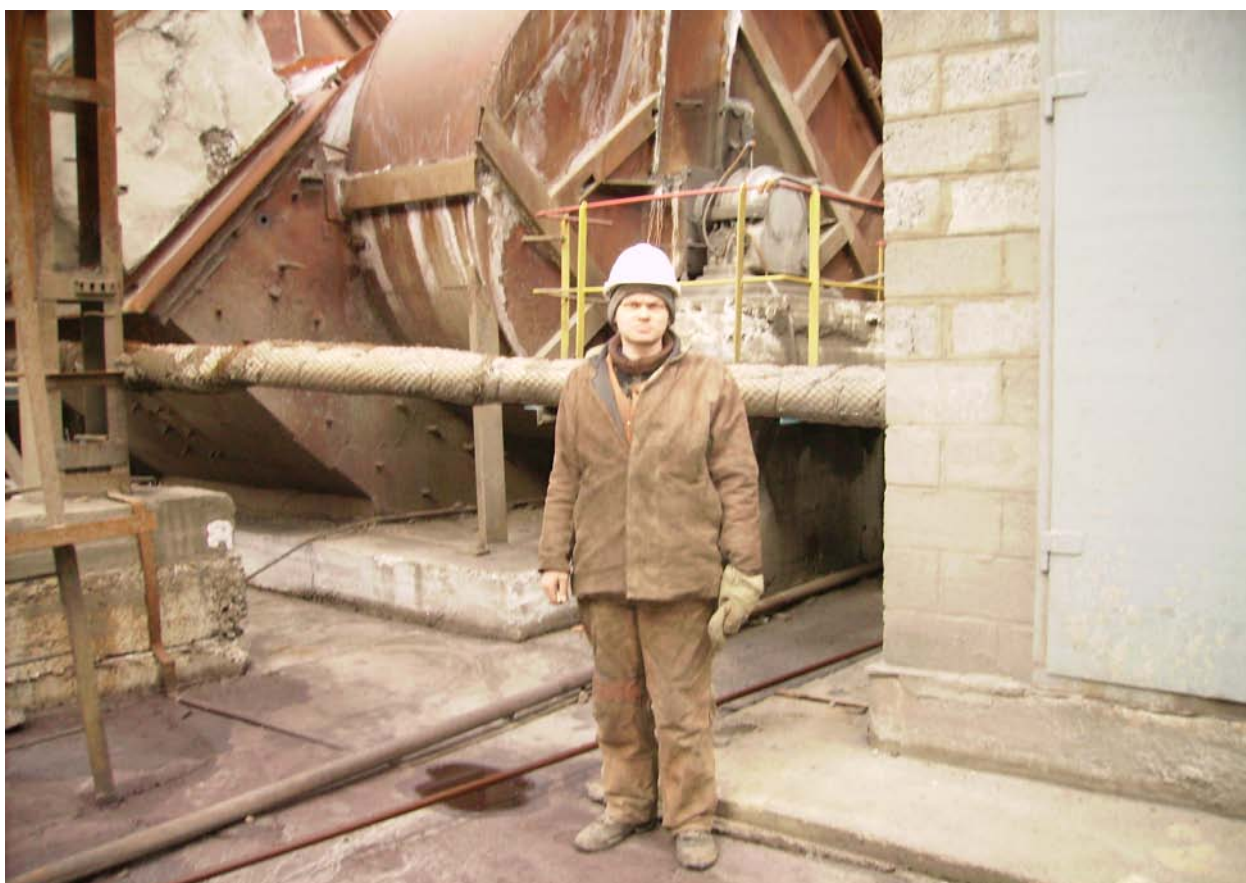
Рисунок 37 – Зовнішній вигляд димососу двостороннього усмоктування
