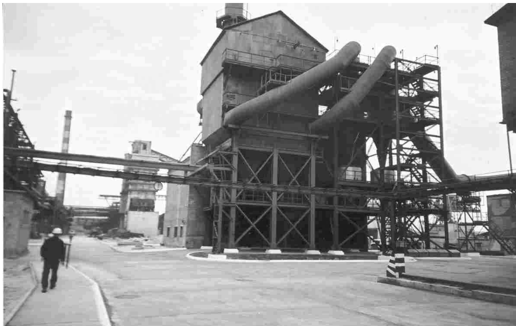
Рисунок 3. Установка БВК коксовой батареи №3 на ОАО «Маркохим»
