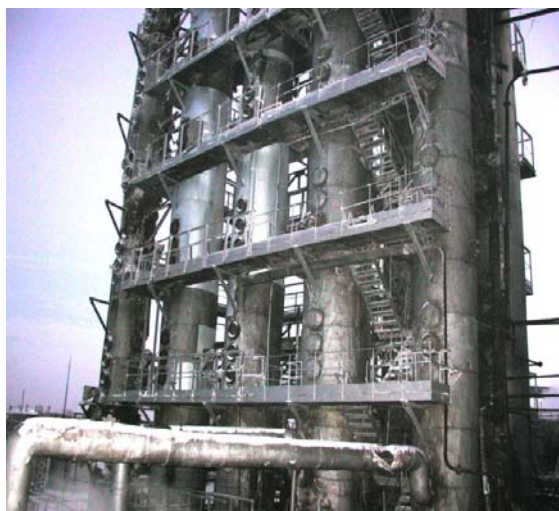
Рис.2 Восстановление ограждающих конструкций ректификационной колонны К-5
