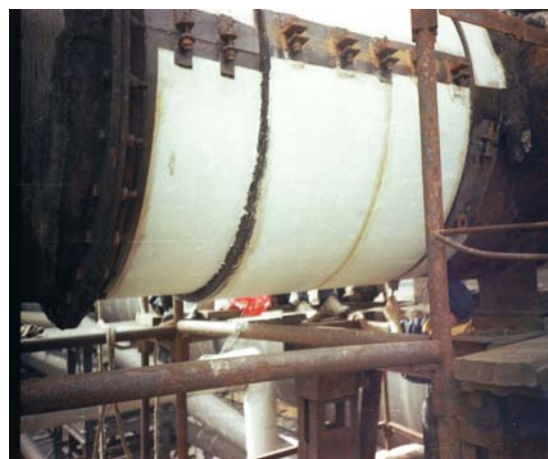
Рис. 3. Внешний вид тройника коксового газа после светополимеризации материала «ТЕХНОПЛАСТ».
