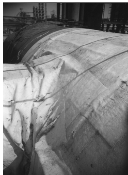
Рисунок 2. Тройник коксового газа ОАО ЯКХЗ после нанесения полиэстерового материала «ТехноПласт ХС»
