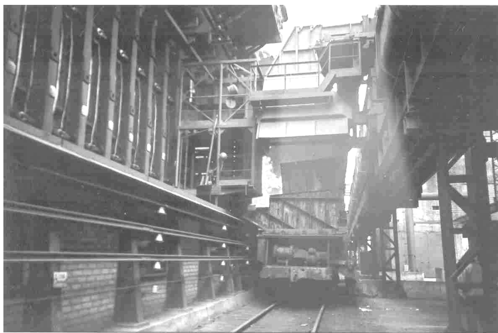
Рисунок 1. Выдача кокса из печи коксовой батареи №3 на ОАО «Маркохим» при работе установки БВК
