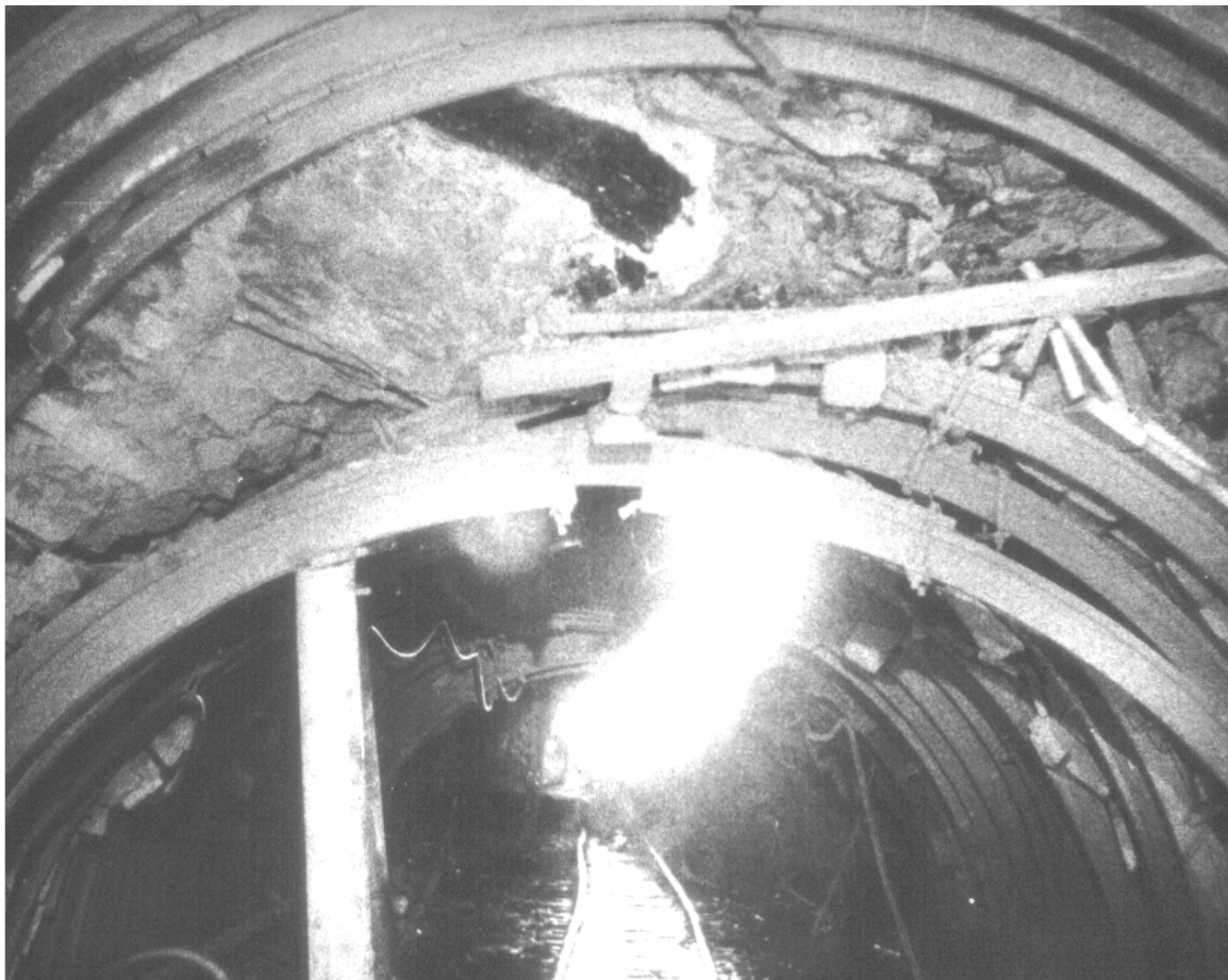
Рис. 3. Вид складки в кровле полевого штрека гор. 893 м шахты им. Стаханова ПО «Красноармейскуголь»
