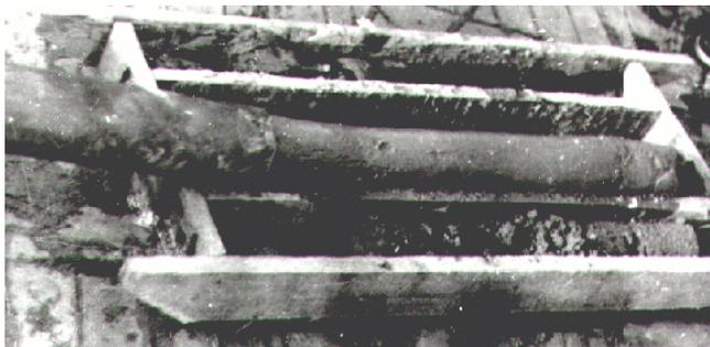
**Рис. 1.40.** Извлечение керна из наклонно размещенной колонковой трубы
