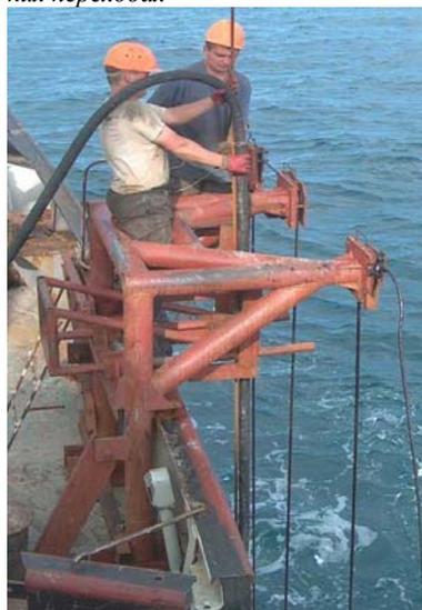
**Рис. 2.25.** Подвязка шланга и троса в процессе бурения на МБ «Центавр»
