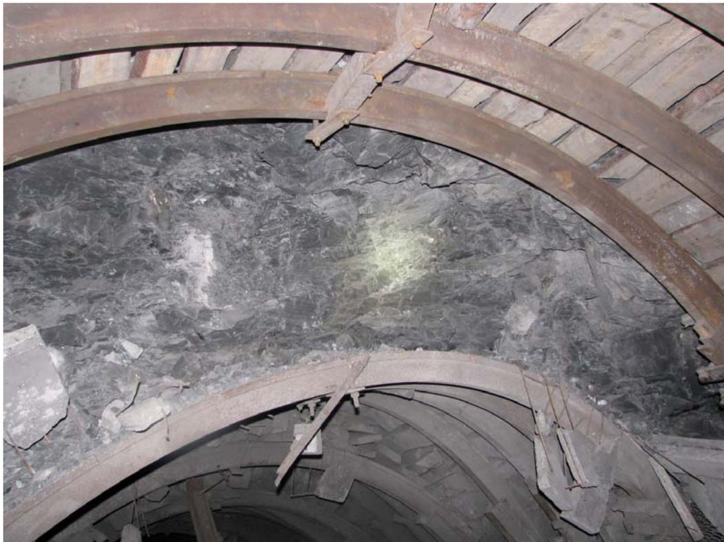
Рис. 7. Общий вид кровли грузового ходка уклона пл.  $m_4^0$  гор. 450 м после демонтажа деформированной рамы крепи на экспериментальном участке
