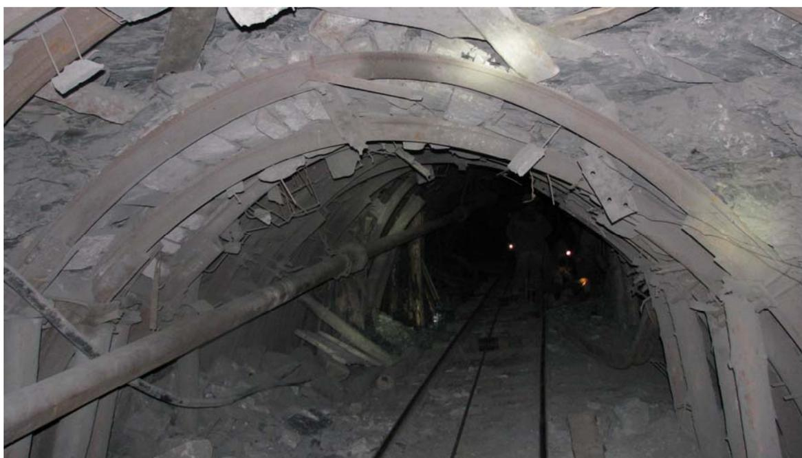
Рис. 6 Общий вид грузового ходка уклона пл.  $m_4^0$  гор. 450 м до перекрепления
