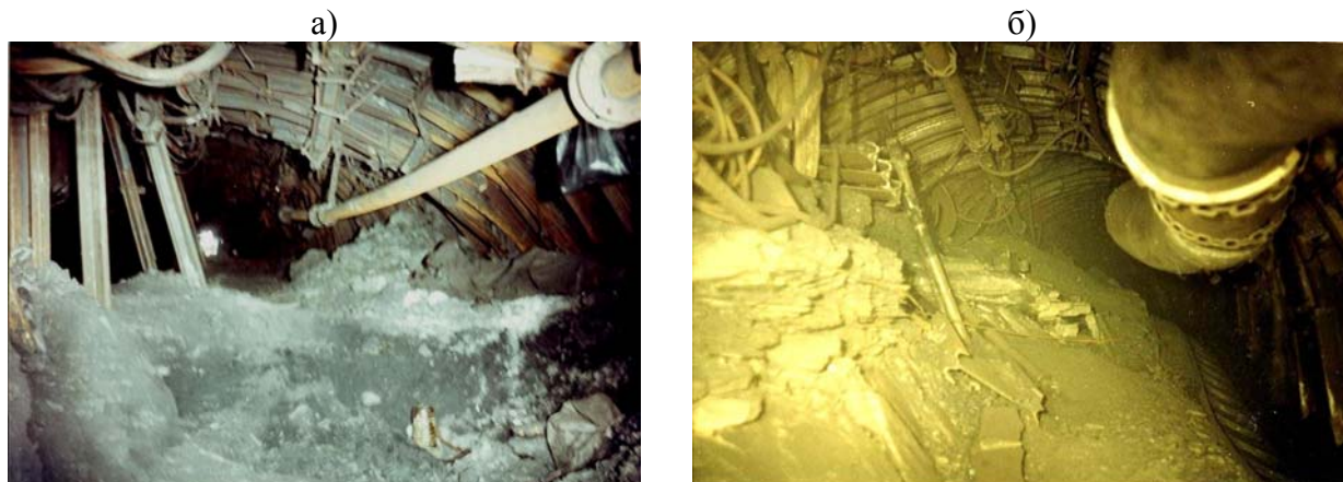
Рис. 4. Состояние пород почвы конвейерного штрека 2-й западной лавы пласта h_{10} на расстоянии 60 м (а) и 120 м (б) от очистного забоя соответственно при двусторонней и верхней подрывках боковых пород
