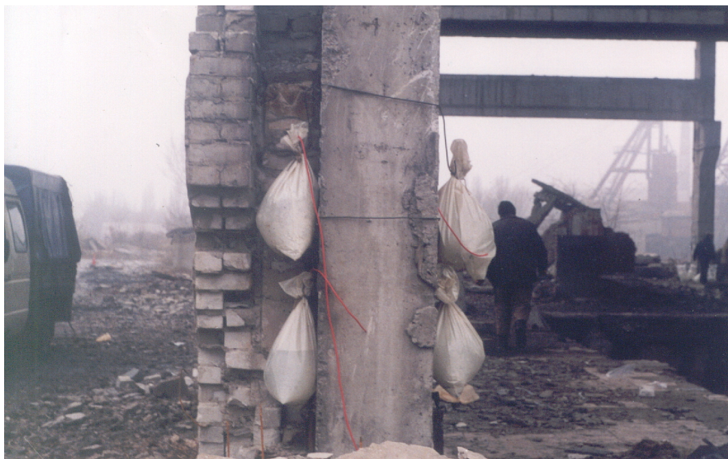
Рис. 1.23 Общий вид колонны с размещенными на ее поверхности накладными зарядами в водяном окружении
