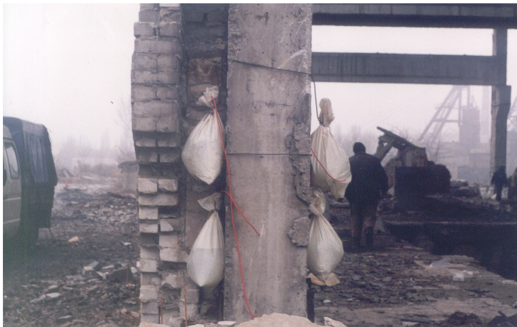
Рис. 1.23 Общий вид колонны с размещенными на ее поверхности накладными зарядами в водяном окружении
