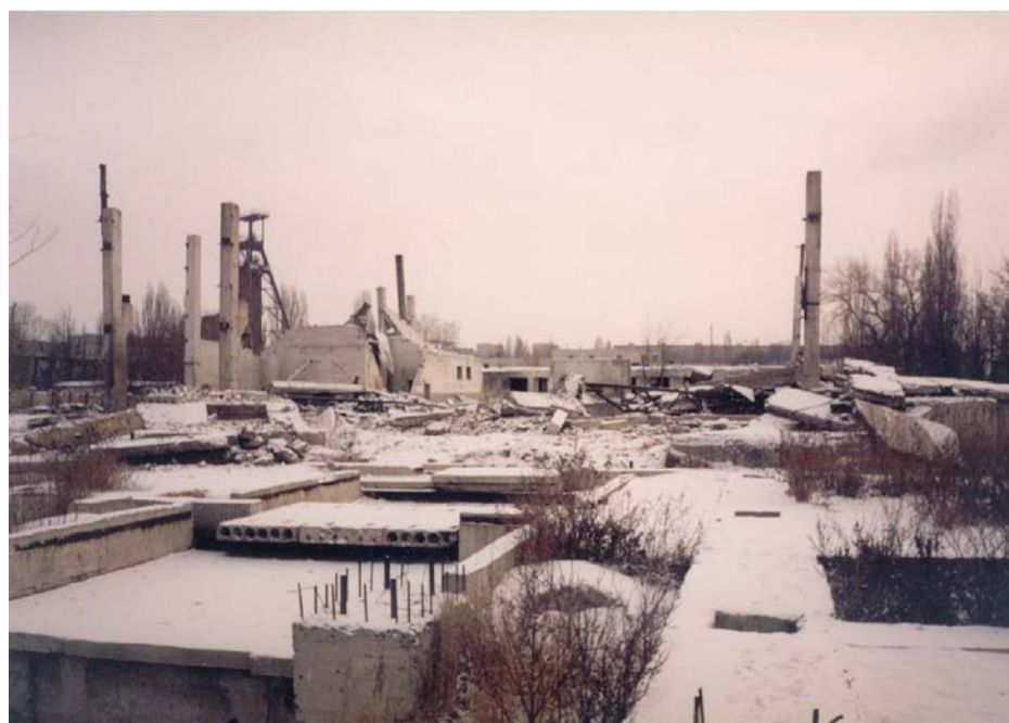
Рис. 1.24 Общий вид здания подъемной машины ствола № 5 шахты им. А.Б. Батова до и после камуфлетного взрывания
