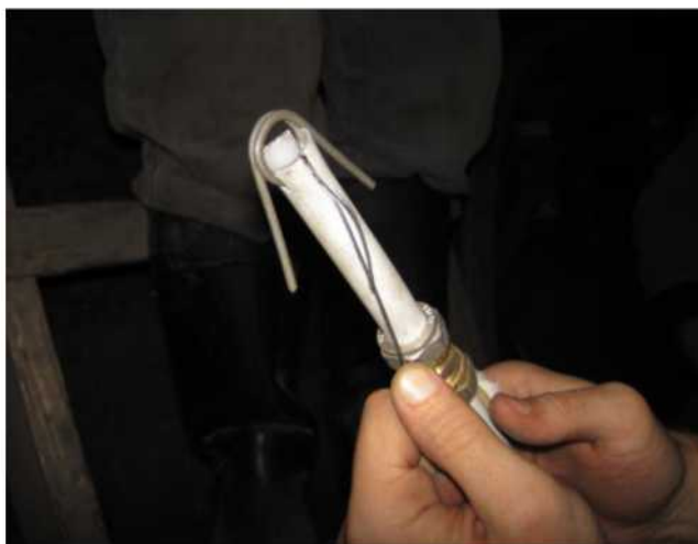
Рисунок 8.4 - Установка якоря в досыльник.
