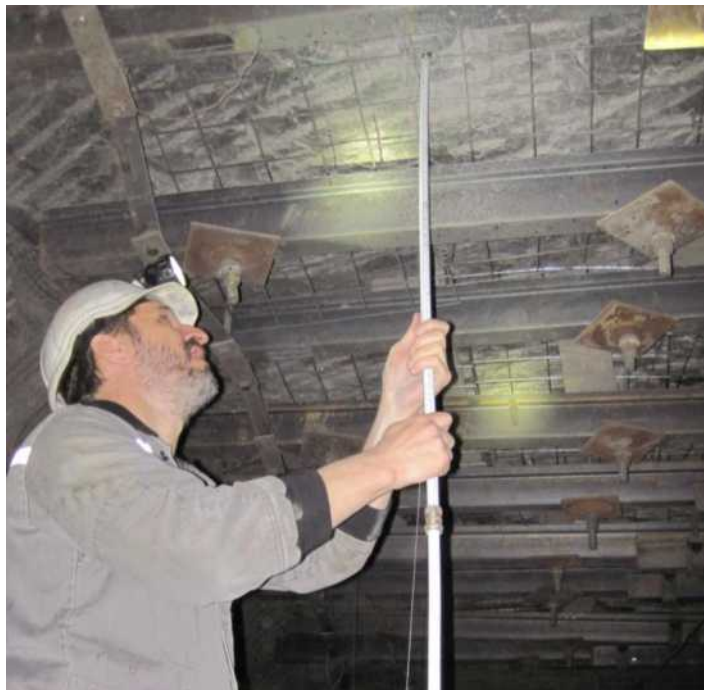
Рисунок 8.5 – Установка якоря в скважину.
