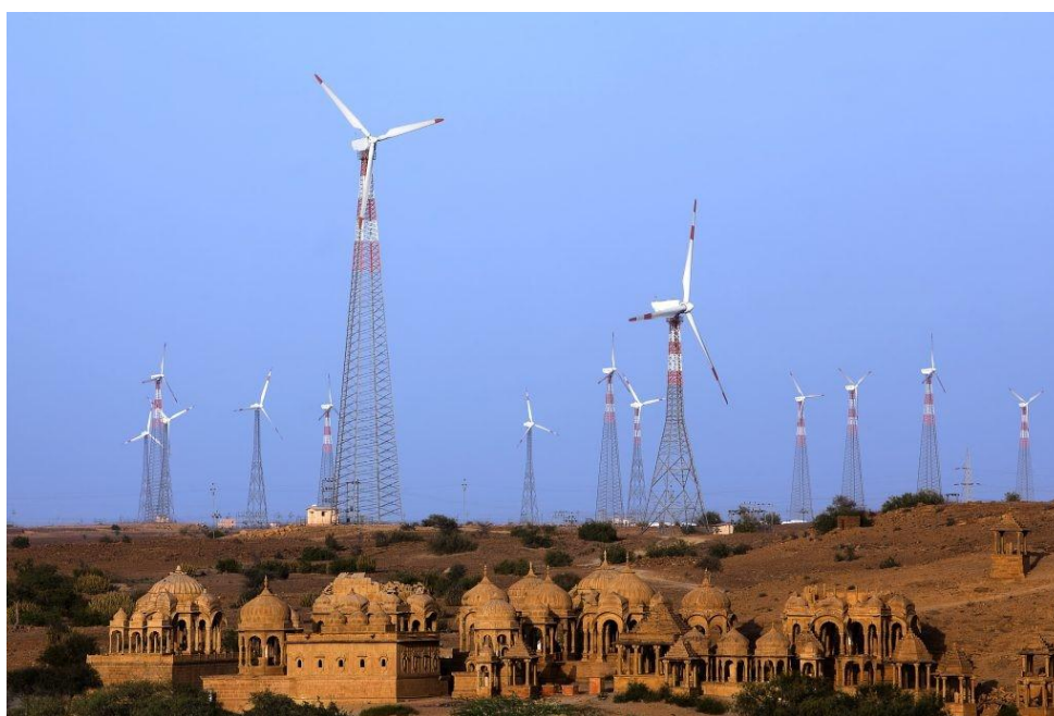
Рисунок 2 – Ветроэлектростанция в Индии
