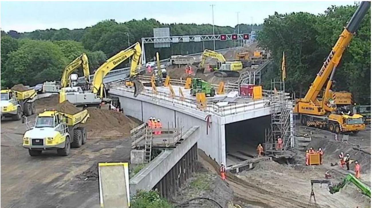
Рисунок 15.3 - Строительство порталной части туннеля: возведение сборной ж/б крепи
